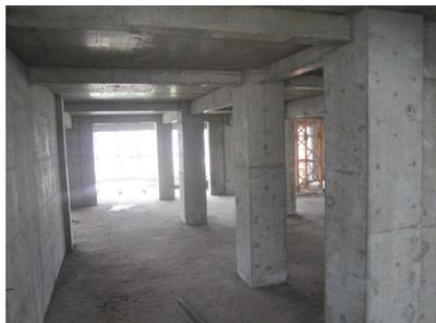
图 0-6 框架—剪力墙结构
