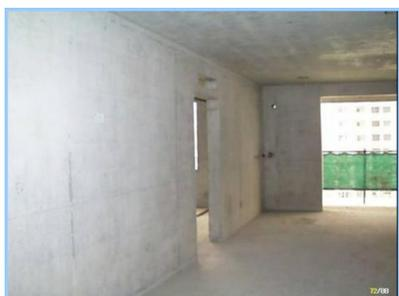
图 0-4 剪力墙结构 1
