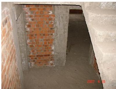
图 0-1 混合结构 1
